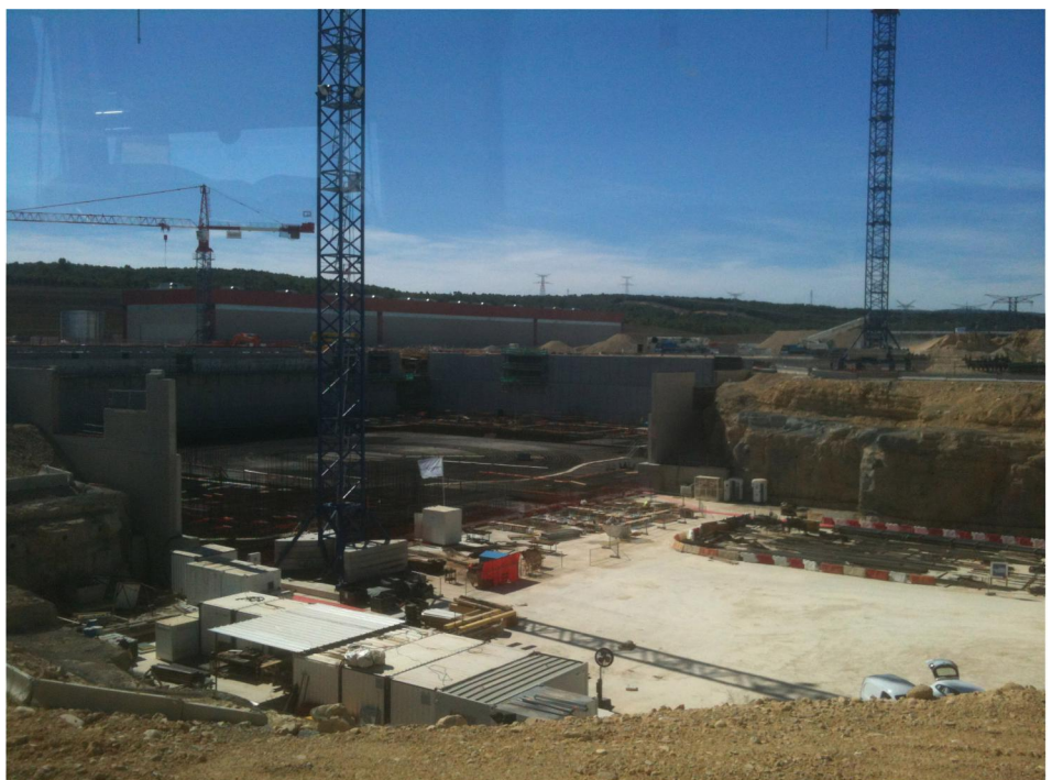
Le chantier avec l'emplacement du futur complexe Tokamak qui pesera 360 000 tonnes.
