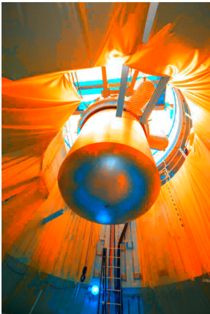
La cuve du RES lors de sa mise en place dans l'enceinte de confinement
