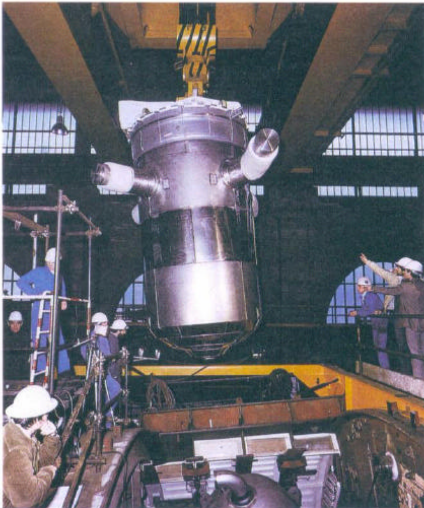
La cuve des SNLE type LE REDOUTABLE est embarquée avant le lancement du navire incliné sur ligne de tins
