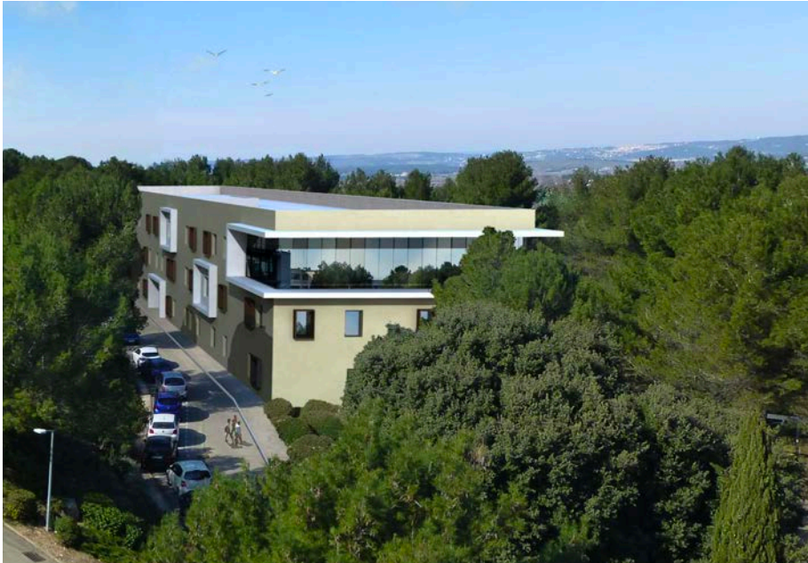
Le futur bâtiment F à Aix, 2500 m 2 de bureaux sur 3 étages. Il accueillera 200 personnes environ
